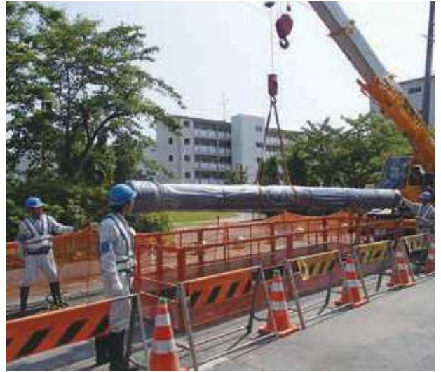
▲水道管取りかえ工事
