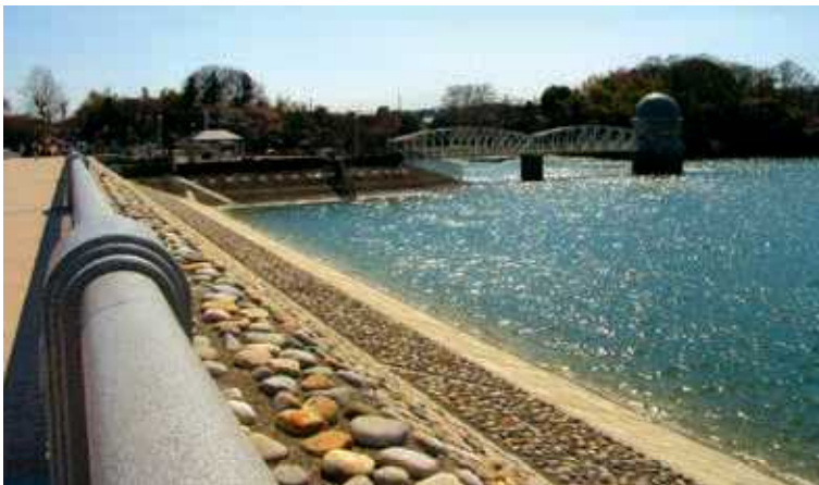
▲堤防の強化工事をした村山下貯水池 (多摩湖)
