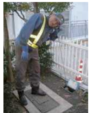
漏水調査の様子
